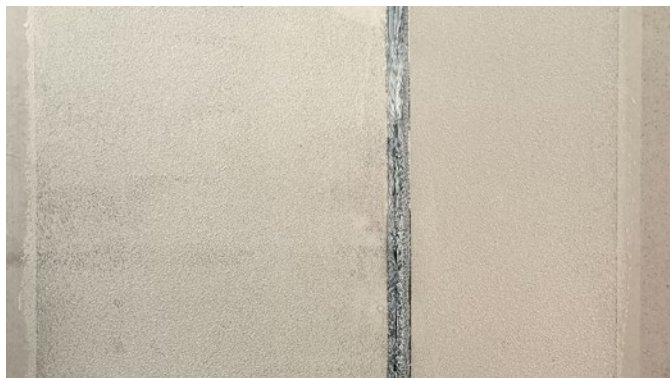
Nanesené lepidlo válečkem na podkladu
