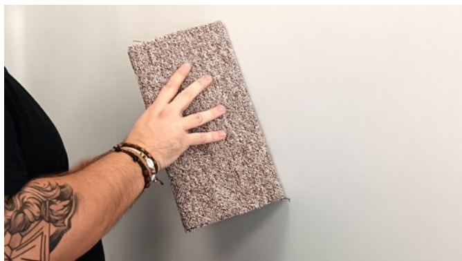
Wypchnięcie powietrza i wygładzenie
