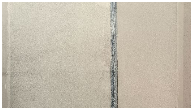
Klej nałożony wałkiem na podłoże
