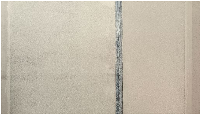
Mit einer Malerrolle auf den Untergrund aufgetragener Klebstoff
