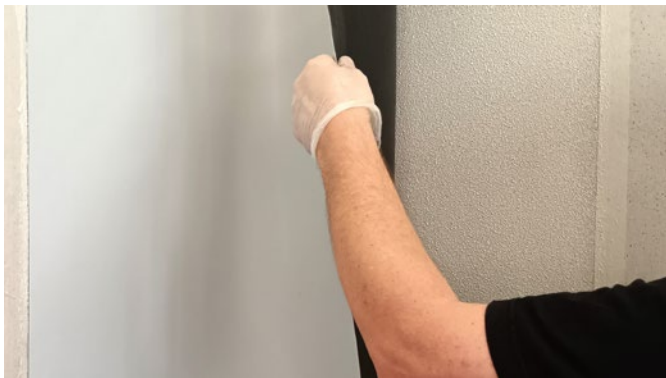
Kleben der MODUL-Verkleidung an der Wand von der Ecke aus
